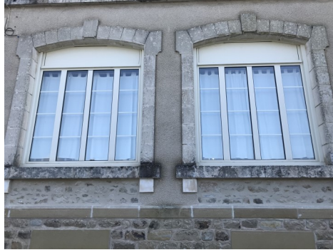
Façade de l'école
