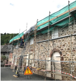
Toit du cabinet médical
